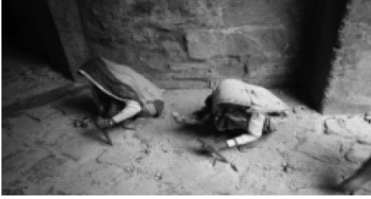
〈그림 13〉 란탄보르성 주민참여 보수공사 현장
