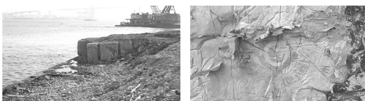
* 저자 촬영 <그림 8> 3부두의 멩텅구리 블록 (좌)추출중인 블록 (우)블록에 표시된 일본 도장
